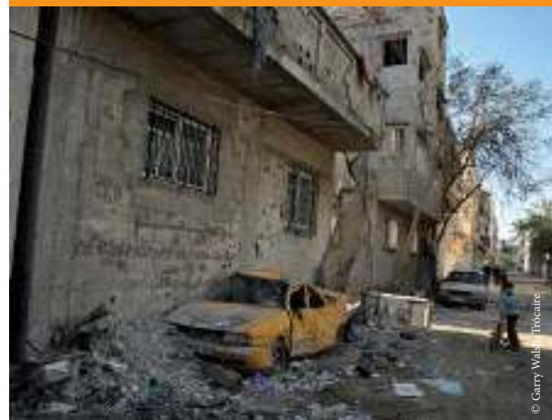
Gaza, área residencial afectada por los bombardeos aéreos de noviembre de 2012
